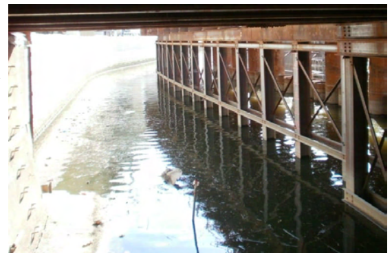
新柳橋そばの都の工事棧橋
