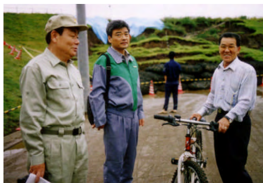
04年10月堤防崩落調査。中央がそね都議（当時）
