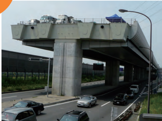
1メートル1億円の外郭環状線工事
